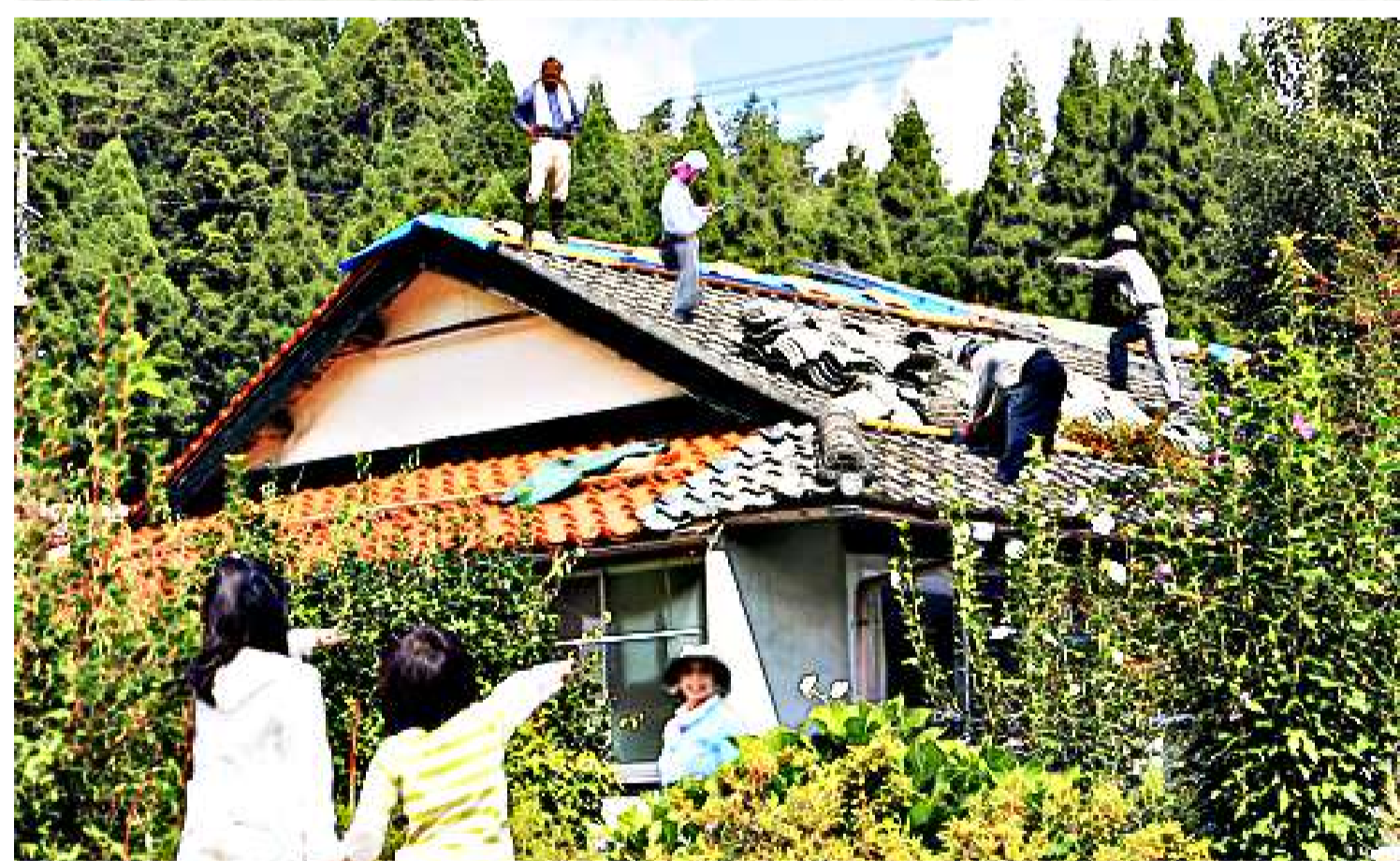
瓦屋根を地域で解体する新たな恒例行事風景となる。
