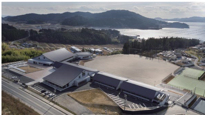
陸前高田市立高田東中学校 (岩手県陸前高田市 2016竣工)
